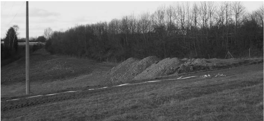
Im Bereich Lenzenberg wurde bereits begonnen
